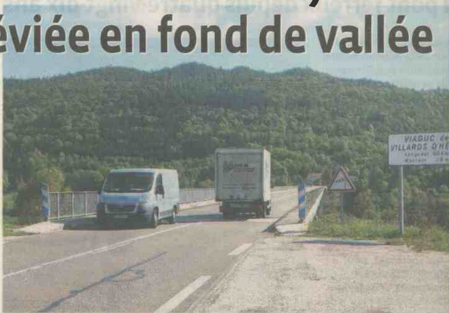
■ Dès lundi, la circulation sur le viaduc dans les deux sens sera impossible. Photo Christelle Klüga
