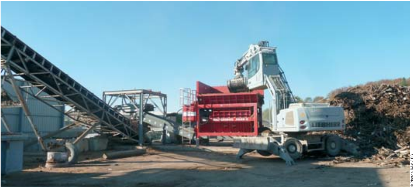
1. L'un des gisements est constitué par des déchets du bâtiment triés à la pelle. Le broyeur primaire (granulométrie 0/250 mm) est suivi par un premier overband, dans l'angle.
